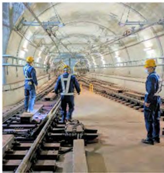
トンネル巡視
