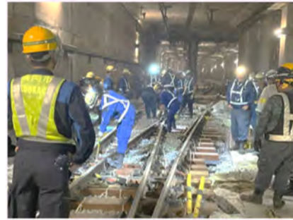
分岐器更新工事
