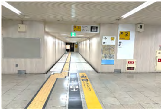
駅コンコース壁面改修後
