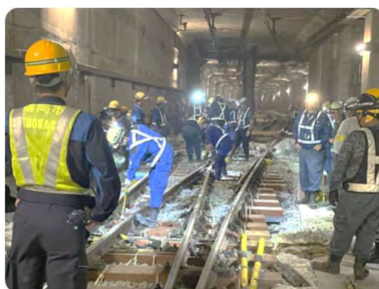
(参考) 夜間工事 (分岐器更新工事)
