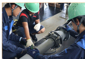
水道管の接合
