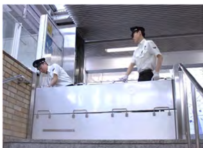
止水板設置訓練 (止水板取付の様子)
