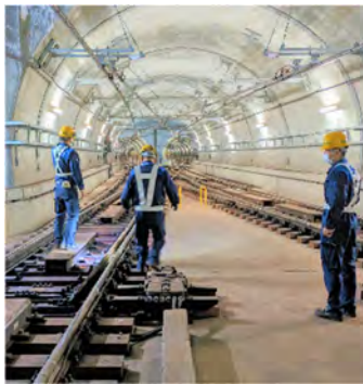
トンネル巡視
