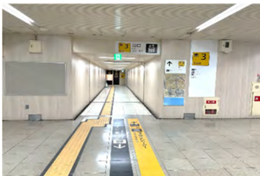
駅コンコース壁面改修後
