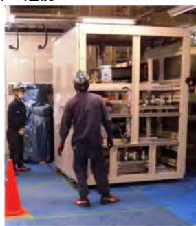
変電所設備更新の様子 （回生インバータ更新）
