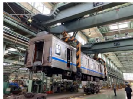
車両検修設備
