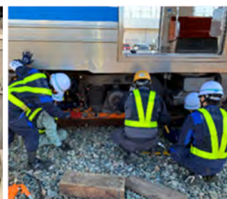
脱線復旧訓練（保守係員）
