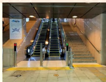
【エスカレーターの増設(博多駅)】
