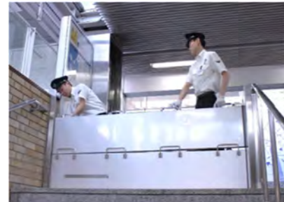
止水板取付の様子
