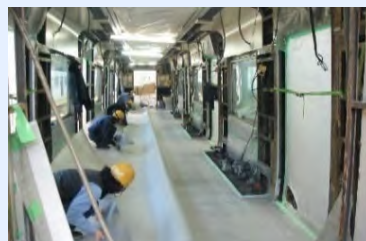
2000系車両大規模改修（内装張替）
