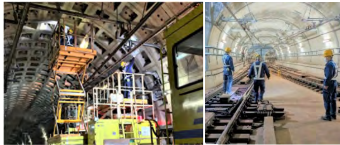
構造物検査（左） トンネル巡視（右）
