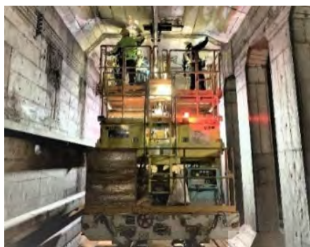
トンネル内点検
