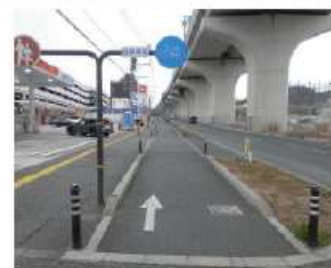
国道 202 号 (西区拾六町)
