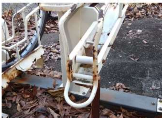
老朽化した駐輪ラック
