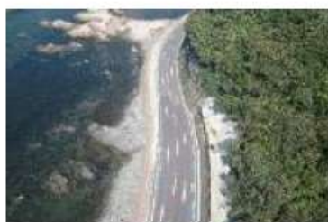
自転車通行空間整備
