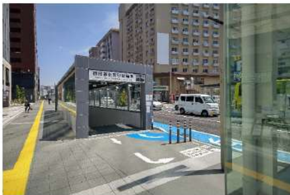
地下空間を利用した駐輪場 (櫛田神社前駅駐輪場)
