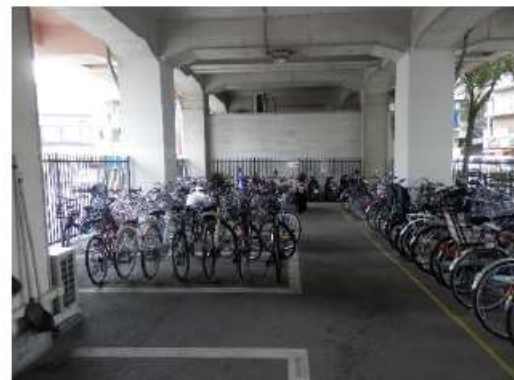
高架下を活用した駐輪場 (高宮駅高架下駐輪場)
