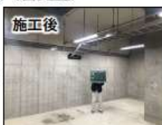
水処理センターの地震対策（耐震壁増設）
