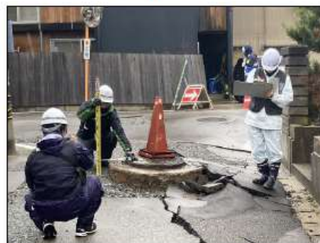
令和6年能登半島地震の被害（金沢市）
