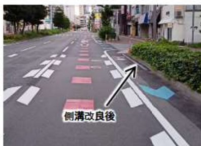
幅の狭い側溝に改良し、通行空間の幅員を広く取った事例 【市道博多駅前線(住吉通り)】
