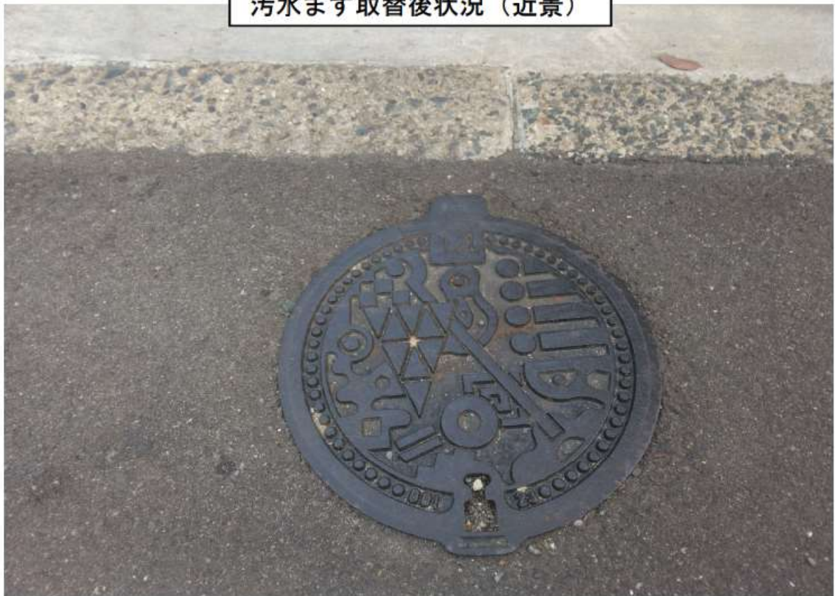
汚水ます取替後状況（近景）
