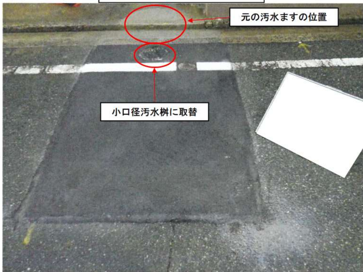
汚水ます取替後状況（遠景）
