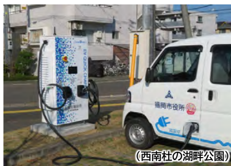
充電設備の設置 (西南社の湖畔公園)
