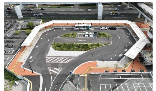
橋本駅駅前広場
