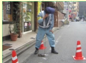
音聴棒を使用した漏水調査
