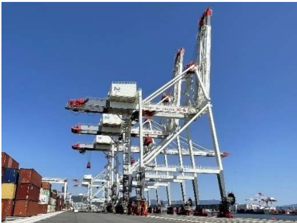
■ガントリークレーン
