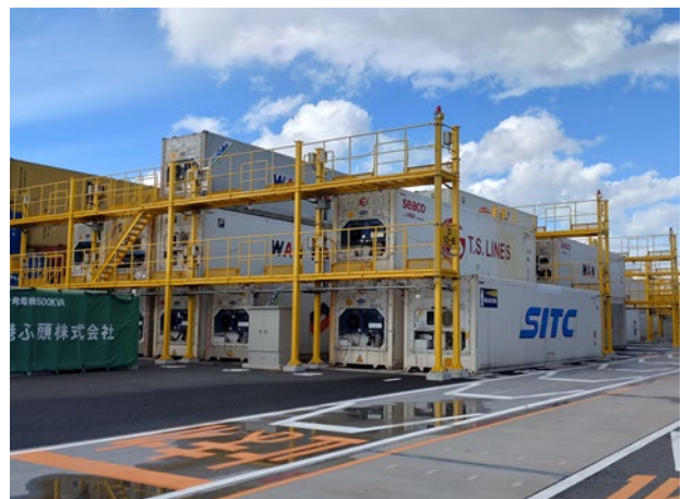
■冷凍コンテナ専用電源
