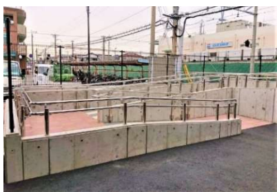
写真2: スロープ設置
