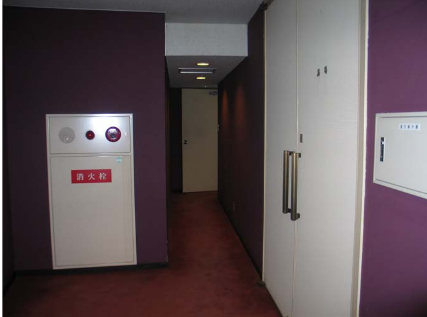
【写真⑭】理事者控室から理事者席へ向かう通路(議場裏の通路)
