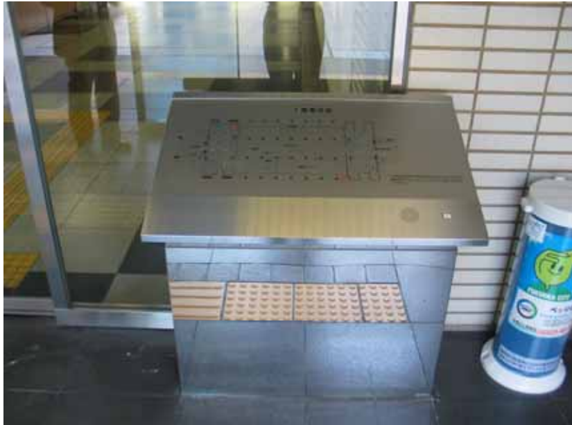
【写真】点字ブロックを延長する箇所
