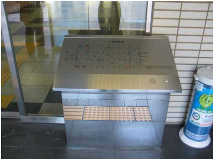
【写真】点字ブロックを延長する箇所
