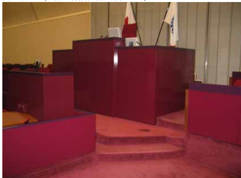
【写真】演壇(2段の階段 段差各15cm)
