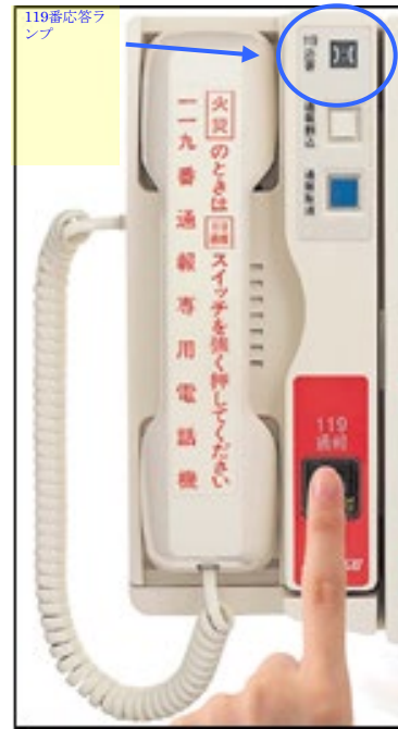
火 災 通 報 装 置
