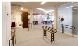
傾斜している床へ注意を引くために、特徴的で目印となる手すりを設置している。
