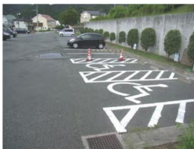
■写真 17 駐車場(車いす使用者用駐車スペース)
