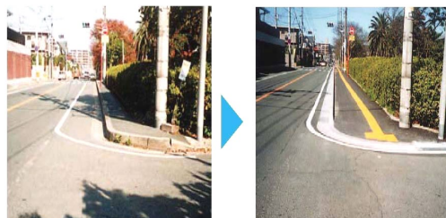
■写真 12 歩道のバリアフリー化 (マウントアップの改善、誘導ブロック設置)
