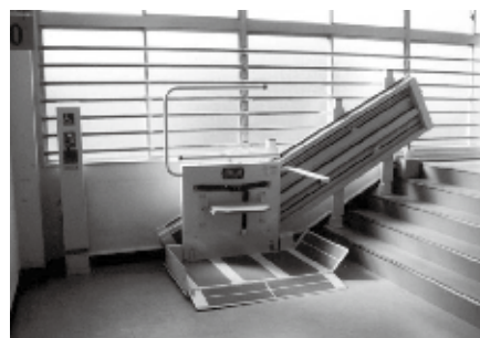
既存の階段に設置した斜行型段差解消機
