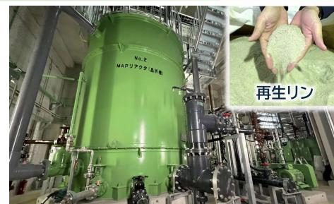
リン回収設備(西部水処理センター)
