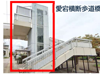
横断歩道橋へのエレベーター設置 New!
