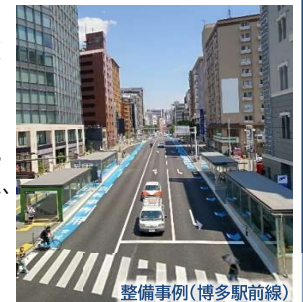
整備事例(博多駅前線)
