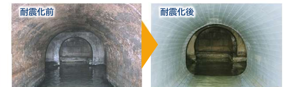
下水道管の耐震化
