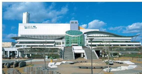
清掃工場（ごみ焼却場）
