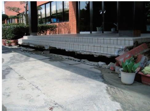
液状化により沈下した西戸崎水処理センター
