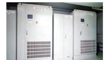
太陽光パネルでつくられた直流の電気を、一般家庭などで使われる交流の電気に変換する装置です。
