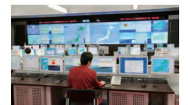
安全で安定的な発電維持のため、遠隔地から運転状況を監視しています。発電量や気温、日射量などは電子データで保管し、異常時は技術者の派遣を要請します。
