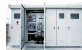
パワーコンディショナでつくられた電圧440Vの交流の電気を、6,600Vに昇圧して送電線に送ります。
