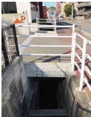
水路の通路橋
