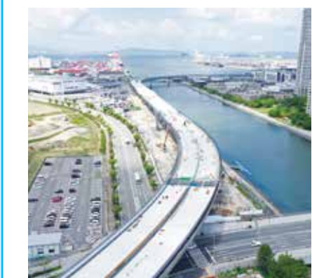
工事の進捗状況(令和2年7月)
