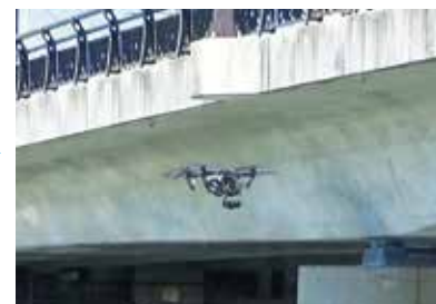
ドローンを活用した点検
