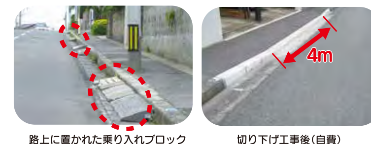
路上に置かれた乗り入れブロック
