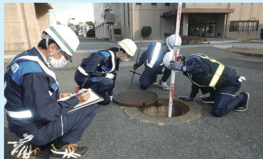
▲地震などで破損した下水道管を調査する訓練
