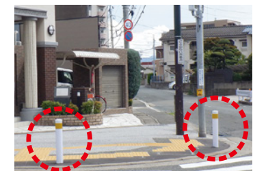
整備後(車止めの設置)
