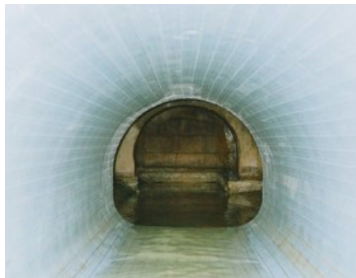
下水道管の更生後
