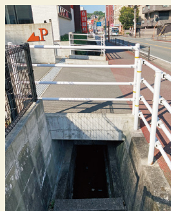
水路の通路橋
