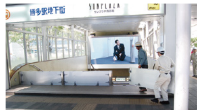
止水板の設置状況
