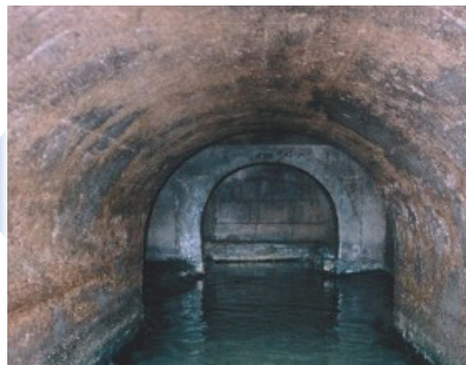
下水道管の更生前
