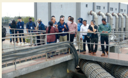
インドの下水処理場を視察する様子
