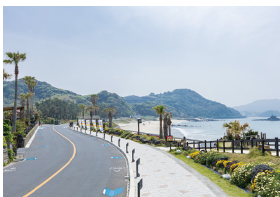
北崎地区の道路整備後
