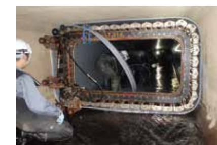
②老朽化した管路のリニューアル工事
