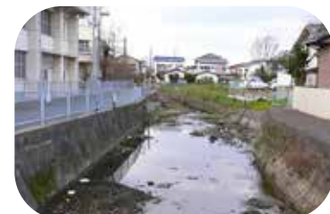
改修前の河川の状況(金屑川)
