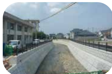
改修後の河川の状況(金屑川)
