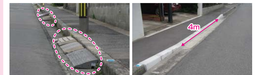
路上に置かれた乗り入れブロック
