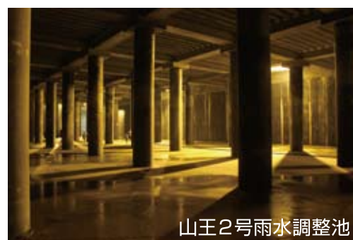
山王2号雨水調整池
