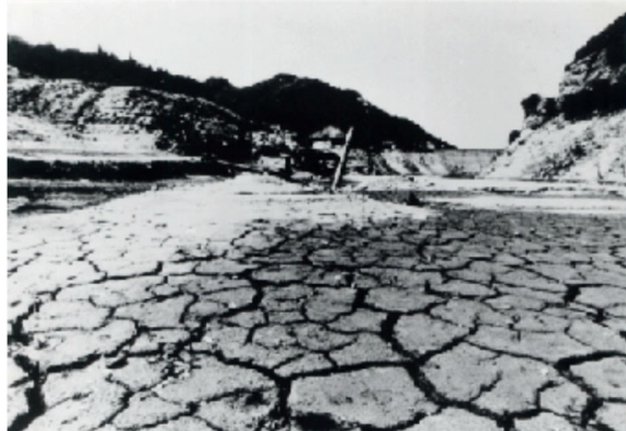
昭和53年の異常少雨で干上がったダム
