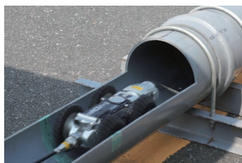
▲下水管内を調査するテレビカメラ
