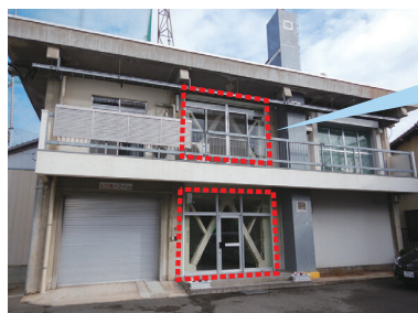
▲耐震補強した城西ポンプ場
