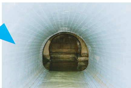
▲内側から改築した下水管
