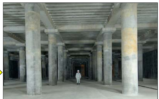
山王2号雨水調整池
