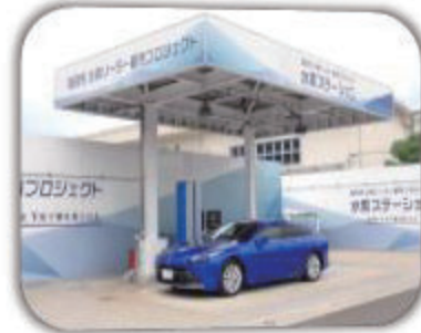
水素ステーション
