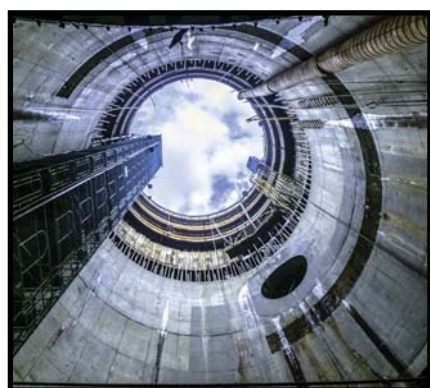
警固特殊人孔(警固小学校敷地内) 地下約36mから撮影
