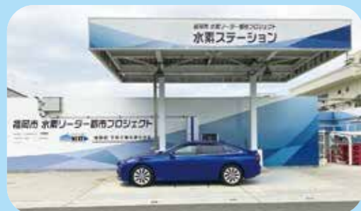
福岡市水素ステーション
