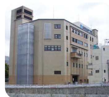
博多駅北ポンプ場
