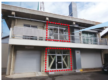
▲耐震補強した下水道施設（城西ポンプ場）
