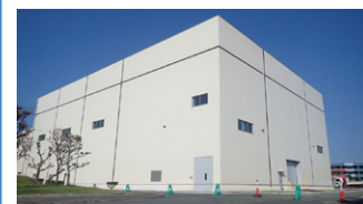
▲下水汚泥固形燃料化施設
