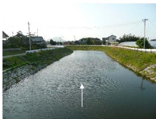
（二級河川周船寺川：整備後）
