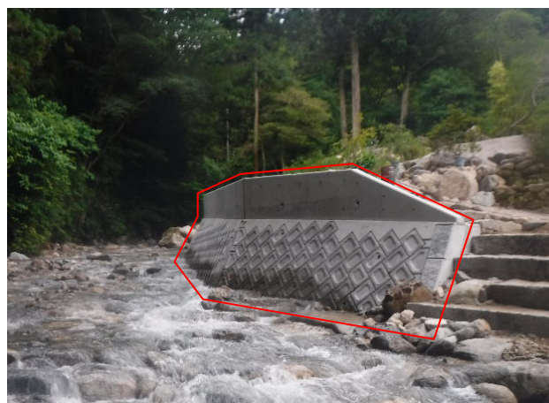
（普通河川荒谷川：護岸改良）
