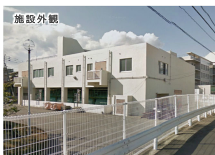
（二級河川吉塚新川排水機場）
