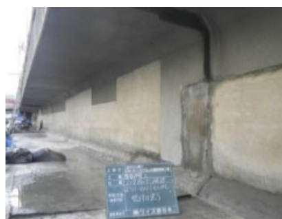
（二級河川七隈川：補修後）
