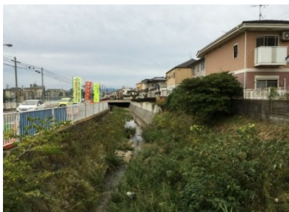
(二級河川金屑川：整備前)
