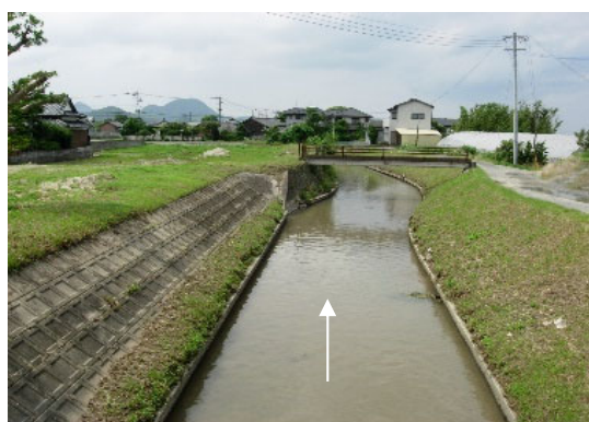
（二級河川周船寺川：整備前）
