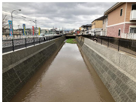
(二級河川金屑川：整備後)
