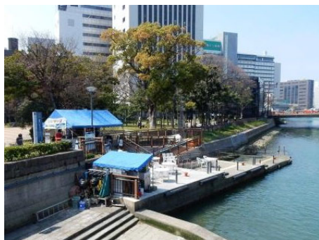
(二級河川那珂川：船着場)
