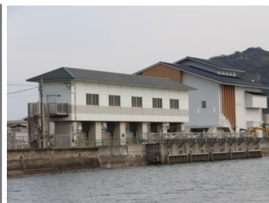
（二級河川水崎川：排水機場）
