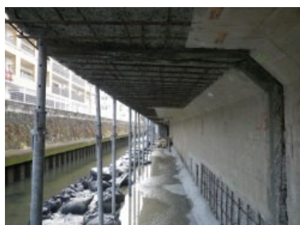
（二級河川七隈川：補修中）
