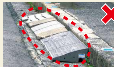
路上に置かれた乗り入れブロック
