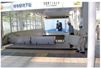
止水板の設置状況 福岡市 水位周知下水道
