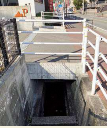
水路の通路橋
