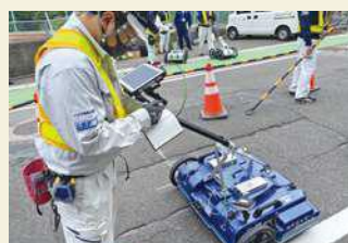
4 地下埋設物の検知状況
