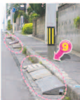
路上に置かれた乗り入れブロック
