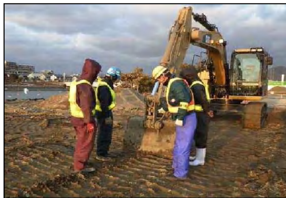
写真③- 2 建設機械の取り扱いの指導状況
