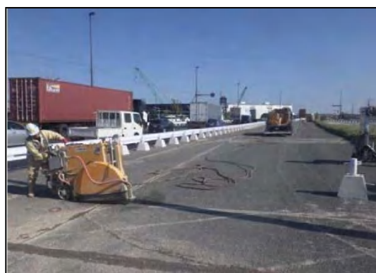
写真⑤-8 建設汚泥の回収状況
