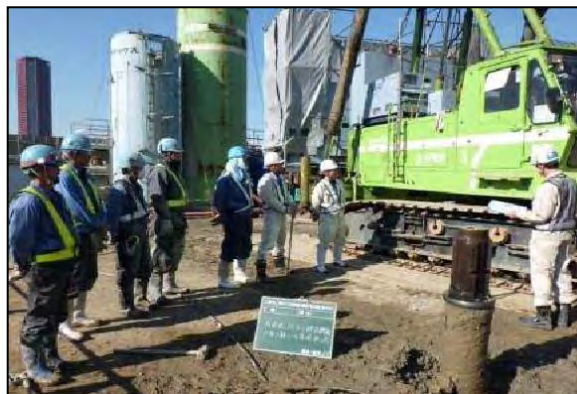
写真②- 2 建設機械の取り扱いの指導状況
