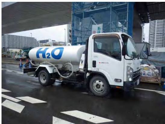
写真⑤-1 施工ヤードの散水設備
