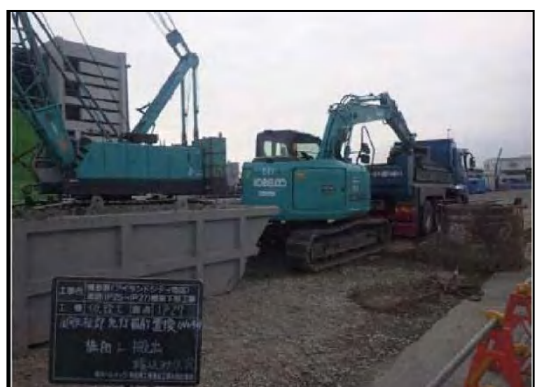
写真⑤-7 発生土の積込状況
