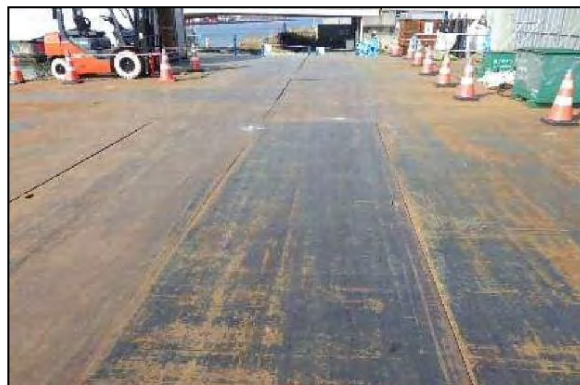
写真④-2 敷鉄板の設置による防じん対策
