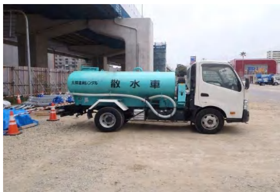
写真⑥-1 施工ヤードの散水設備
