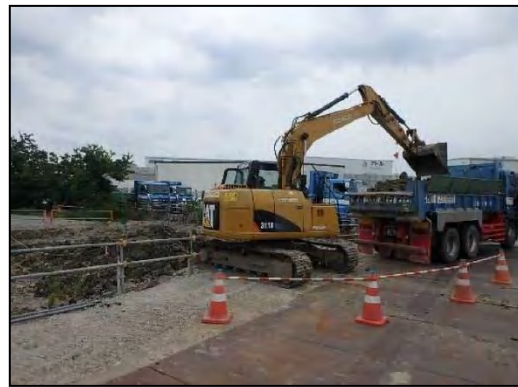
写真④- 6 建設汚泥の積込状況
