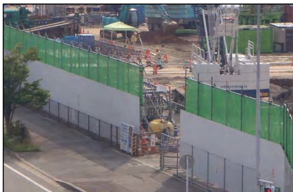
写真③-3 防音パネル等の遮音対策
