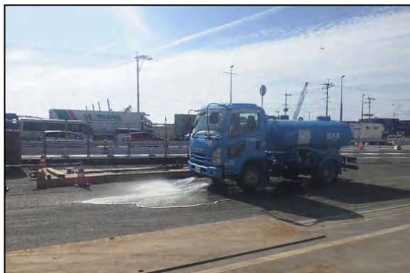
写真⑤- 1 施工ヤードへの散水状況
