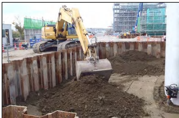
写真③-7 発生土による埋戻し
