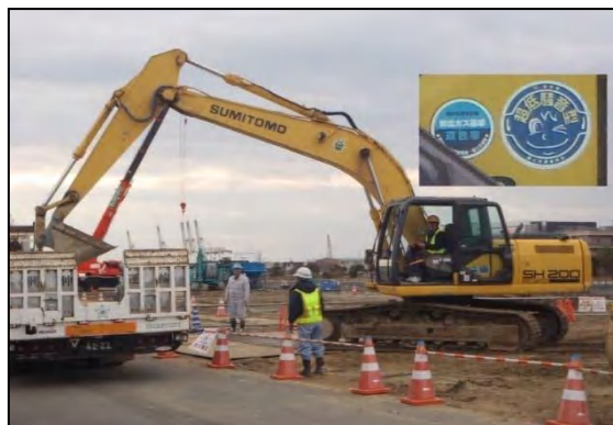
写真③- 4 低騒音型建設機械の使用状況
