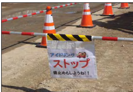
写真①- 3 建設機械の取り扱いの啓発状況
