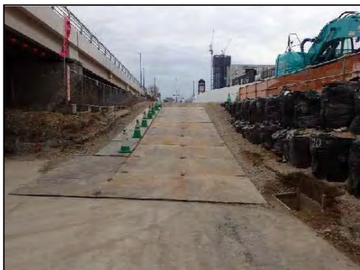
写真⑤-1 敷鉄板の敷設状況
