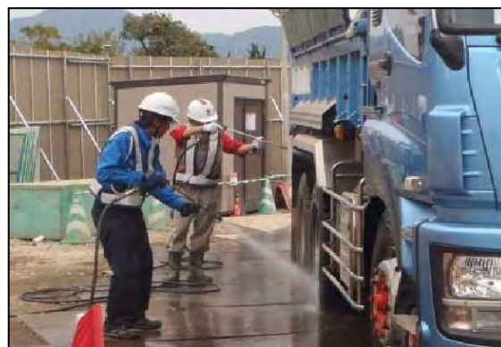
写真②- 6 工事用車両のタイヤ洗浄状況
