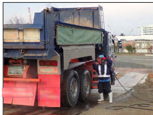
写真①- 6 工事用車両のタイヤ洗浄
