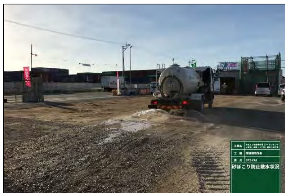
写真⑤-1 施工ヤードへの散水状況
