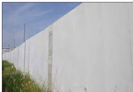
写真③-6 防音パネルの設置
