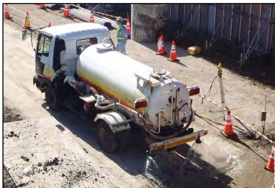
写真①- 1 施工ヤードへの散水状況
