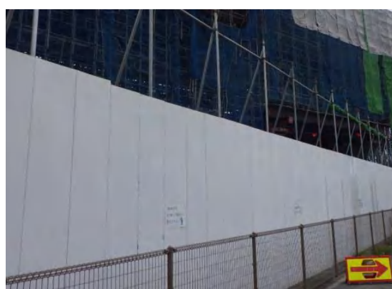
写真③-4 防音パネルの設置による遮音対策
