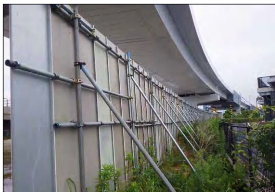
写真⑤-3 防音パネル等の遮音対策
