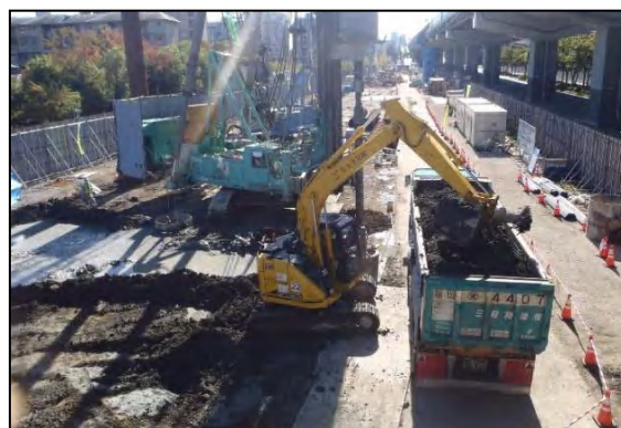
写真①- 8 建設汚泥の積込状況
