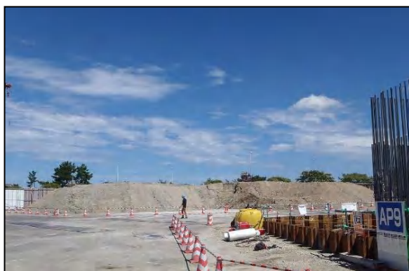
写真①- 7 発生土の仮置き
