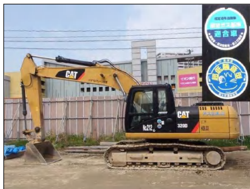
写真①- 4 低騒音型建設機械の使用状況
