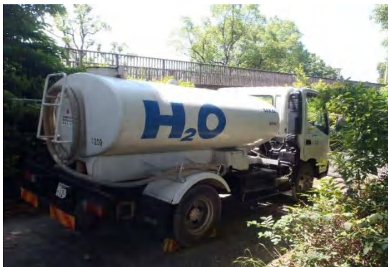
写真①-1 施工ヤードの散水設備
