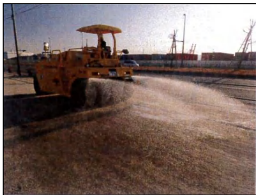
写真③- 1 施工ヤードへの散水
