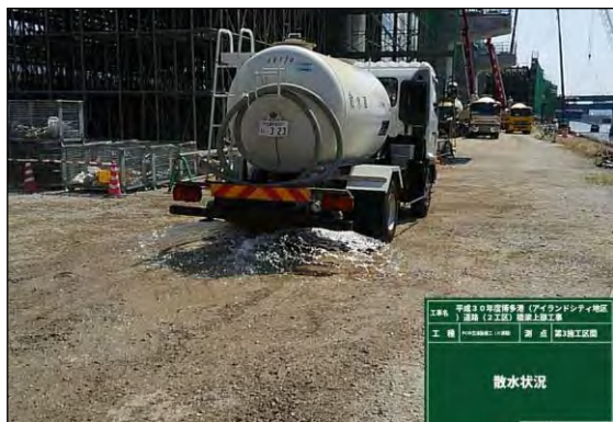
写真③-1 施工ヤードへの散水状況
