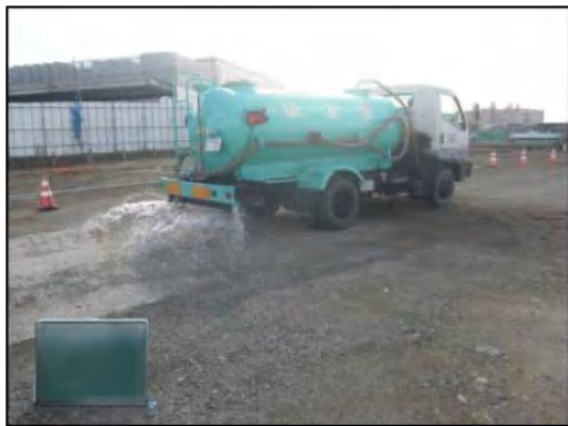
写真①- 1 施工ヤードへの散水
