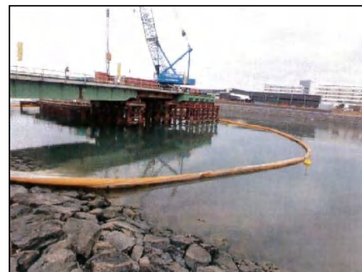
写真②- 8 汚濁防止膜の展張
