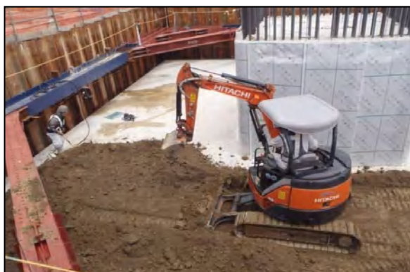
写真②-7 発生土による埋戻し
