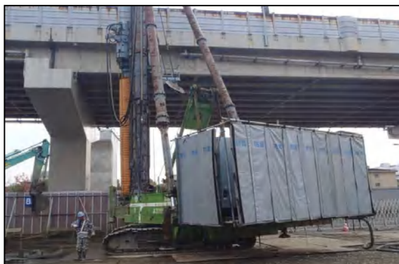
写真①- 5 低振動工法の採用 (鋼管ソイルセメント杭工法)
