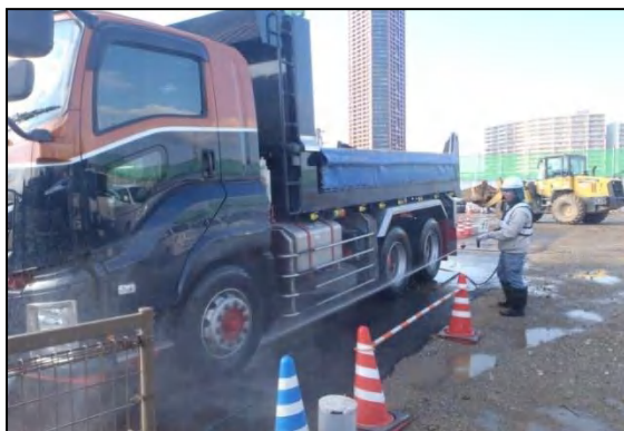
写真③- 5 工事用車両のタイヤ洗浄状況
