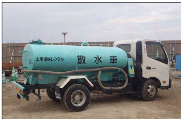
写真②-1 施工ヤードへの散水設備
