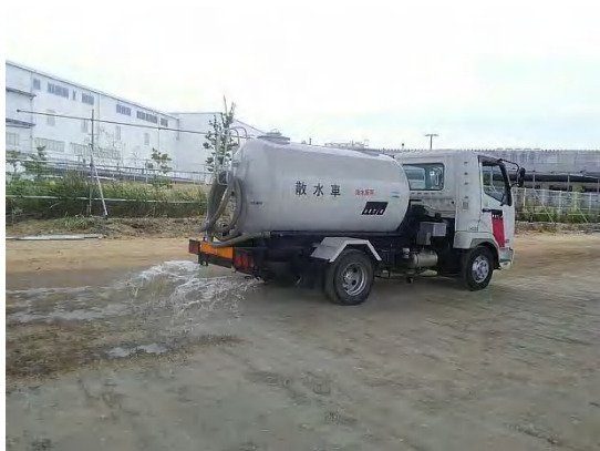
写真③-1 施工ヤードの散水状況
