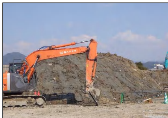
写真②- 8 発生土の仮置き
