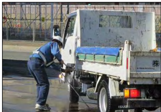
写真①- 7 工事用車両のタイヤ洗浄状況
