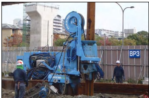
写真②- 5 低振動工法の採用 (鋼矢板打設の圧入工法)
