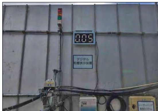
写真③- 2 粉じん表示計による確認
