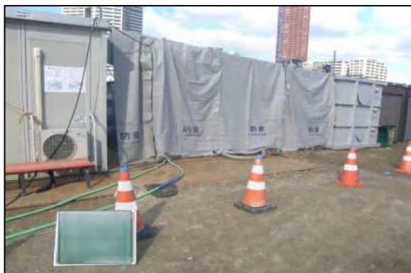
写真①- 3 防音シート等の遮音対策
