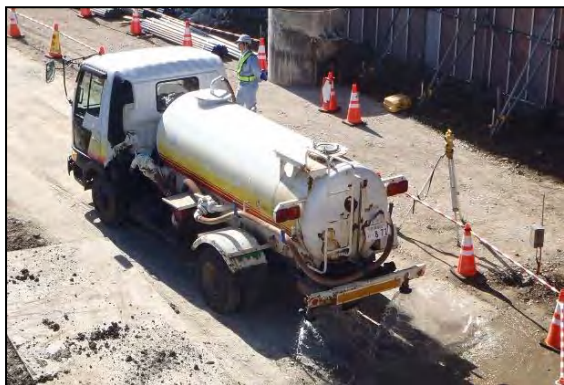
写真①- 1 施工ヤードへの散水状況
