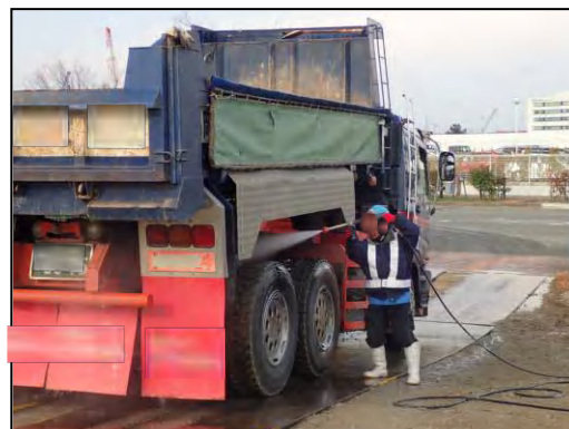
写真①- 6 工事用車両のタイヤ洗浄
