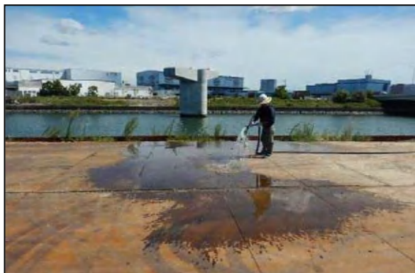
写真④-1 施工ヤードへの散水
