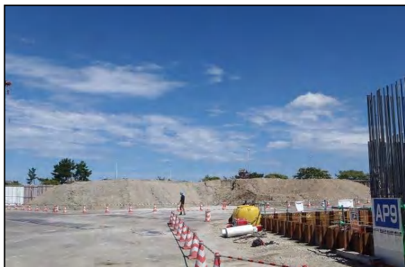
写真①- 7 発生土の仮置き
