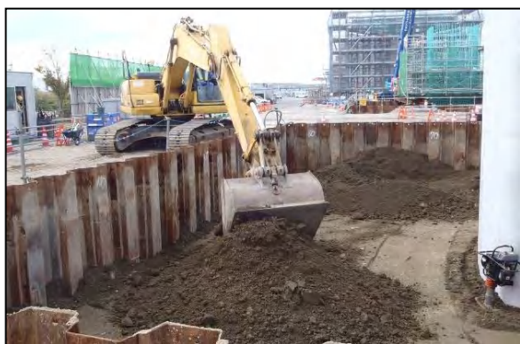
写真③-7 発生土による埋戻し
