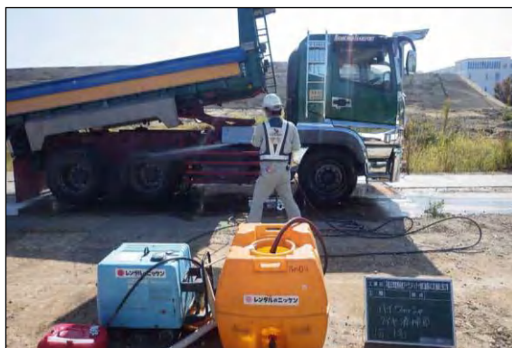
写真⑤- 5 工事用車両のタイヤ洗浄状況
