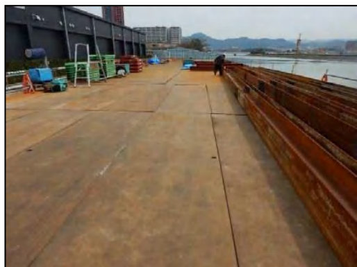
写真②- 5 敷鉄板の設置
