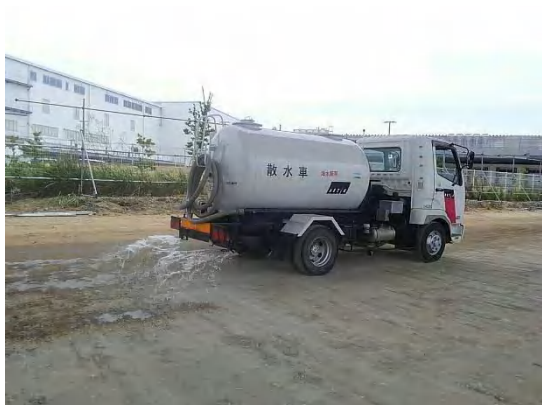
写真③-1 施工ヤードの散水状況
