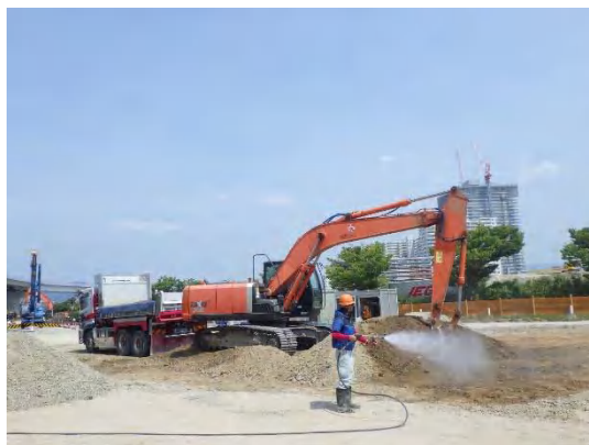
写真③-2 散水状況
