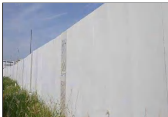
写真③- 6 防音パネルの設置
