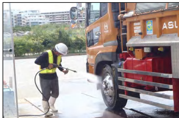
写真③-6 工事用車両のタイヤ洗浄状況
