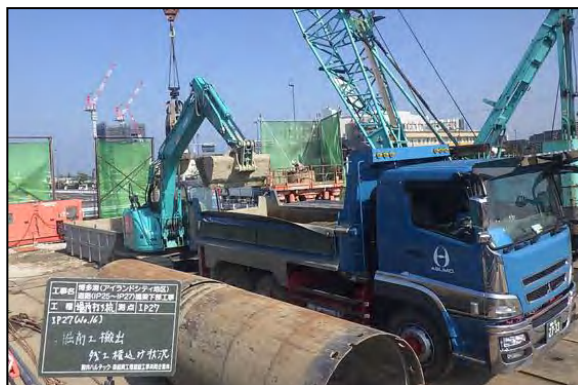
写真⑤- 6 発生土の仮置き場への運搬状況
