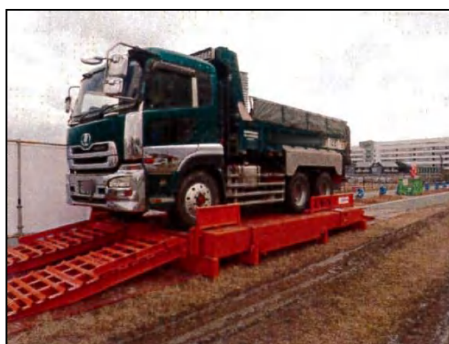
写真③- 4 工事用車両のタイヤ洗浄（乾式）
