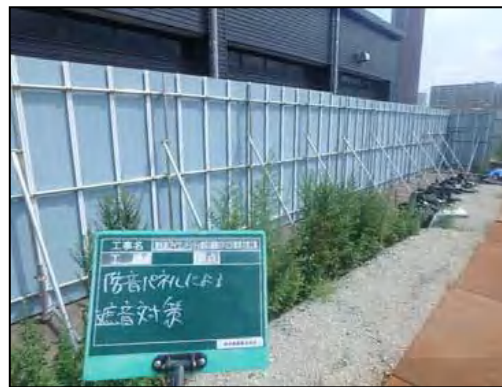
写真④- 2 防音パネル等の遮音対策
