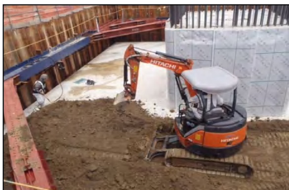
写真②- 7 発生土による埋戻し
