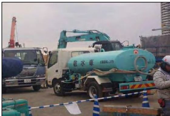
写真③-1 施工ヤードへの散水設備
