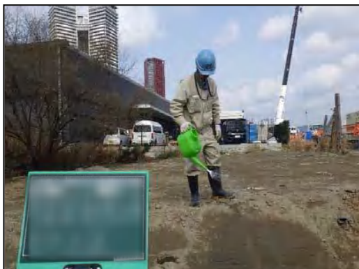
写真②- 1 粉じん飛散防止剤の散布
