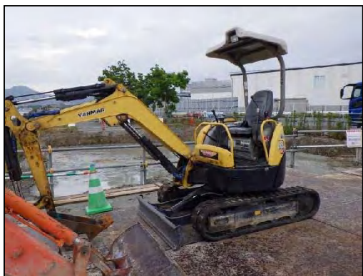
写真④- 3 低騒音型建設機械の使用状況 (全景)
