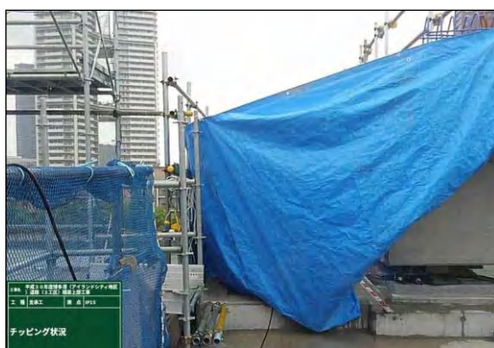
写真③- 4 沓座チッピング作業時の粉じん対策（外側）
