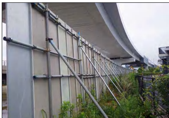
写真⑤- 3 防音パネル等の遮音対策
