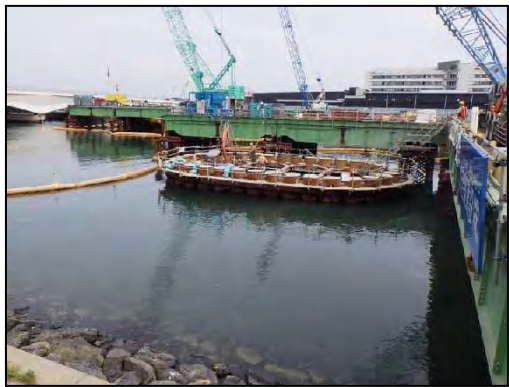
写真④- 5 汚泥防止膜の展張状況
