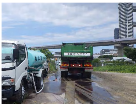
写真③-6 工事用車両のタイヤ洗浄設備
