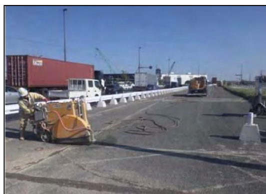
写真⑤-8 建設汚泥の回収状況
