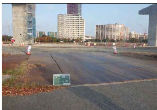
写真③- 8 敷鉄板の設置による粉じん対策
