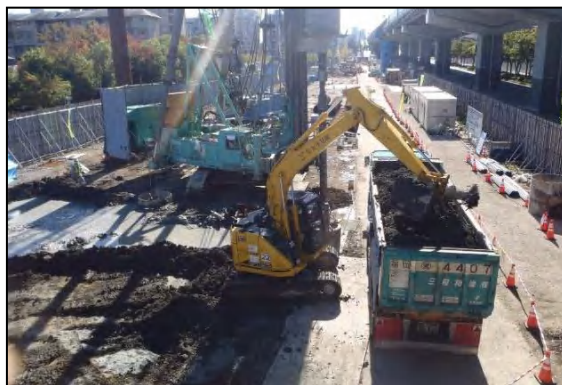
写真①- 8 建設汚泥の積込状況
