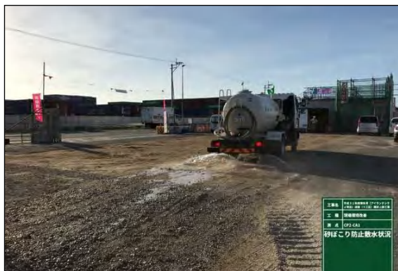
写真⑤- 1 施工ヤードへの散水状況
