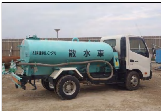
写真②- 1 施工ヤードへの散水設備
