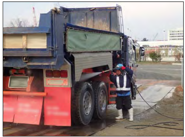
写真①-6 工事用車両のタイヤ洗浄
