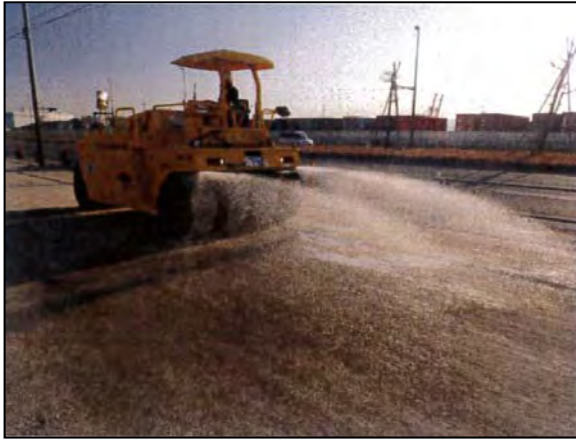
写真③-1 施工ヤードへの散水
