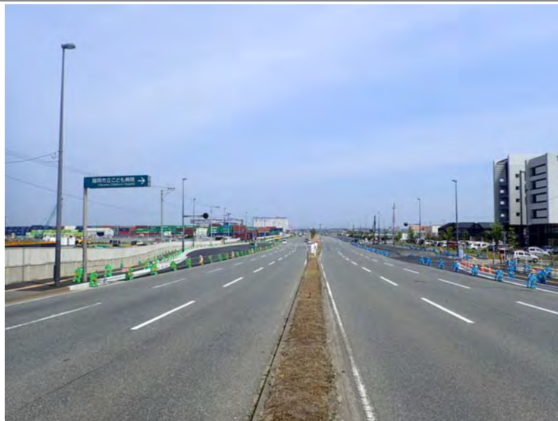
工事進捗状況写真
