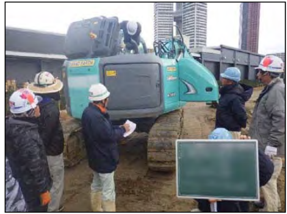
写真②-2 作業者に対する建設機械の取り扱いの指導
