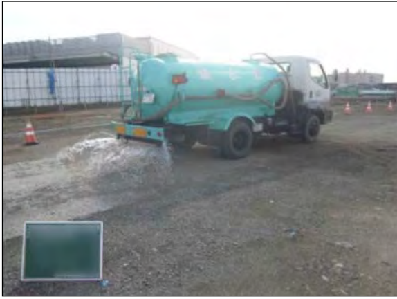
写真①-1 施工ヤードへの散水
