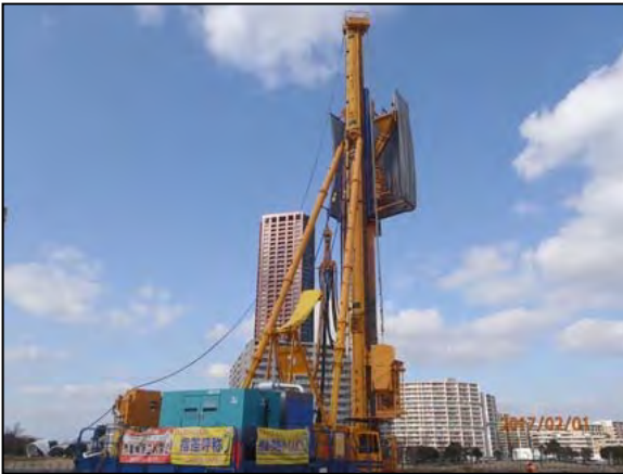
写真①-5 低騒音・無振動工法の採用
