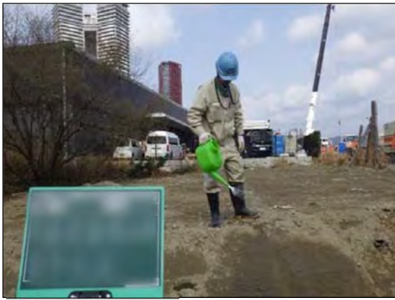
写真②-1 粉じん飛散防止剤の散布
