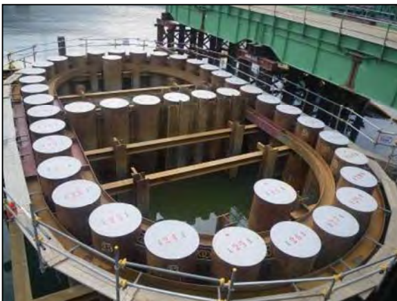
写真②-5 敷鉄板の設置
