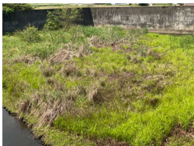
土砂の堆積による機能低下
