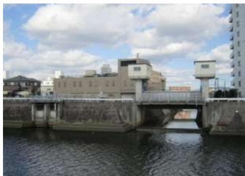
上牟田川排水機場
