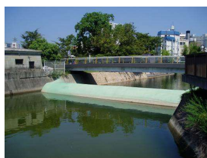
博多川可動井堰（上流）
