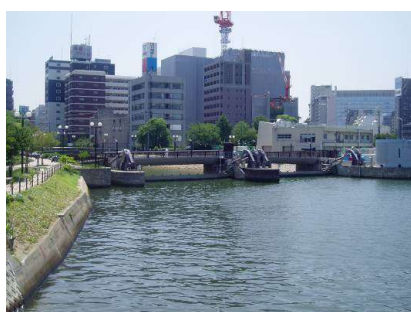
博多川可動井堰（下流）
