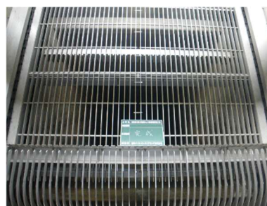
更新完了 （排水機除塵機スクリーン）
