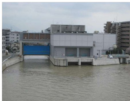
綿打川排水機場
