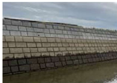
更新完了 （護岸の再構築）
