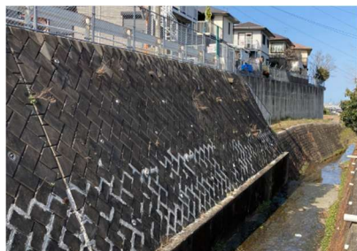
修繕完了（目地補修）
